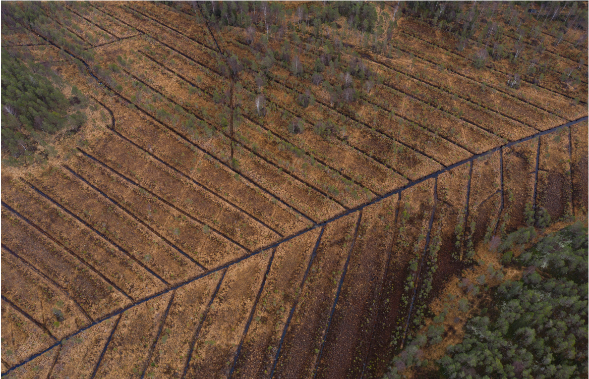
Grøfting av Kavlebrumosen ved Ør viser hvor store inngrep grønning av myr representerer ( Foto: Jørn Bøhmer Olsen)
